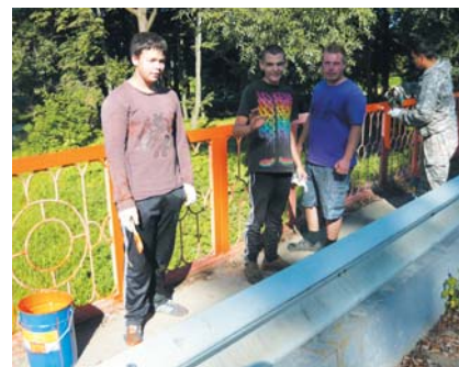
Покраска мостика к монастырю.
