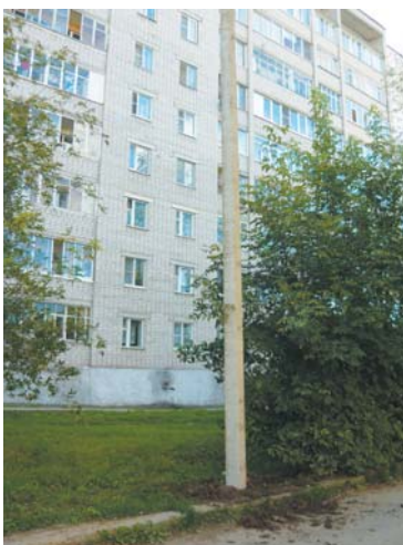
Ул. Ак. Королёва, д. 2: новая опора для уличного освещения.
