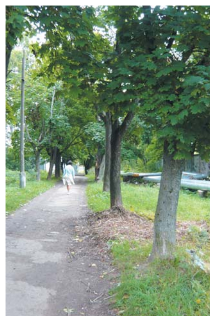
Тротуар к АХПК нуждается в реконструкции: ремонте освещения, уборке мусора, вырубке поросли и т.д.
